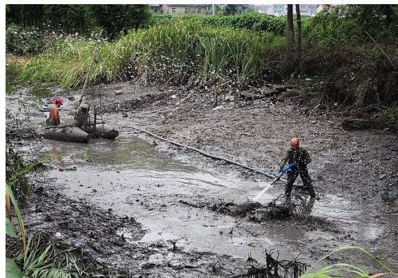
图 2-5 水力冲挖清淤
